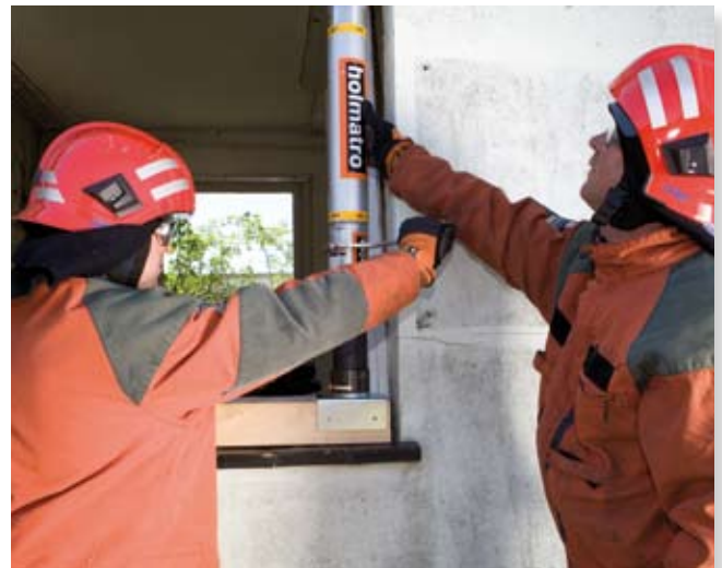
Ablak kitámasztás kézi menetes típusú támhengerekkel, amit egy körmös kulccsal lehet meghúzni (Lásd az alsó képet)
