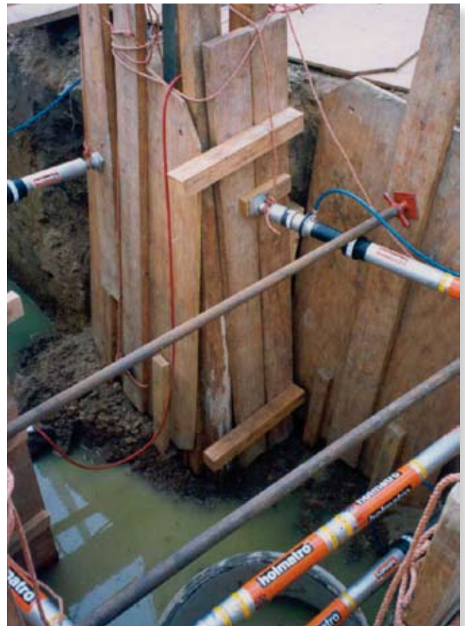
Pneumatikus önzáró „Auto-lock” támhengerek az árkokban
