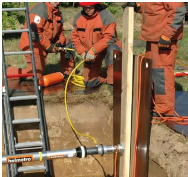
Pneumatikus önzáró „Auto-lock” nagyon alkalmas távrolói kitámasztásra árkokból mentésnél
