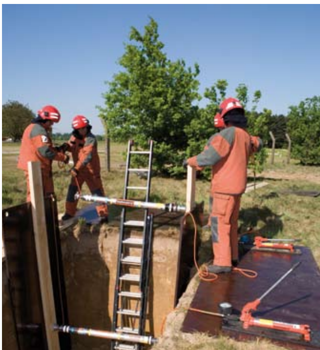
„Távolról támasztás” hidraulikus önzáró „Auto-lock” támhengerrel
