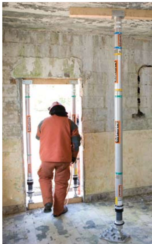
Összedőlt épület hozzáférhetőségének és kijáratának biztosítása, támhengerekkel és gerendákkal.
