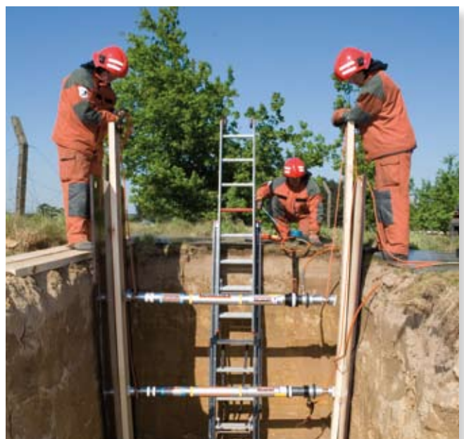
„Távolról támasztás” hidraulikus rögzítőanyás „Locknut” támhengerrel
