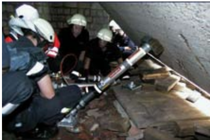
Összedőlt szerkezet stabilizálása és emelése hidraulikus rögzítőnyás „Locknut” rendszerrel
