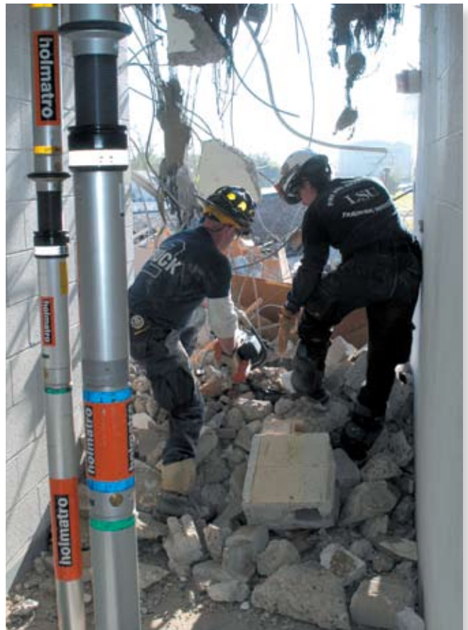
Összedőlt épület stabilizálása és emelése hidraulikus rögzítőnyás „Locknut” rendszerrel
