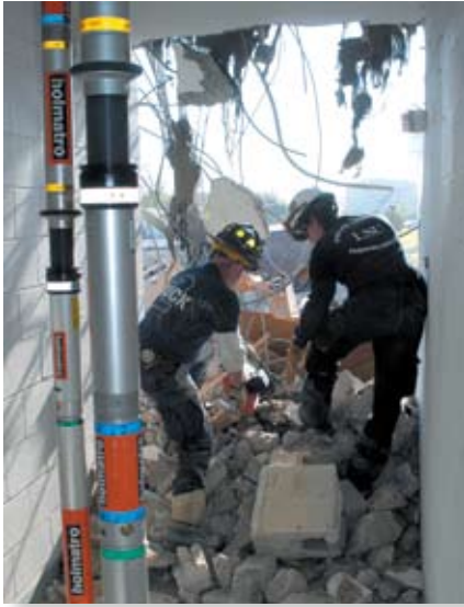
Összedőlt épületből mentés
