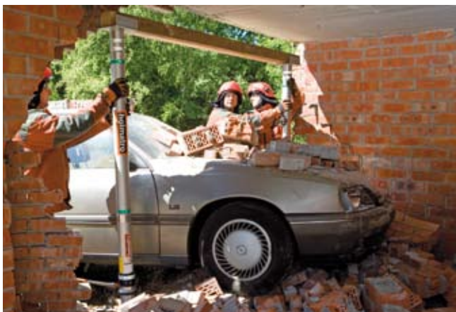
Épület stabilizálása 2 támhengerral gerendával és gerenda kengyel. A hidraulikus rögzítőnyás „Locknut” támhengereket kézi pumpával lassan, óvatosan hosszabbítjuk ki
