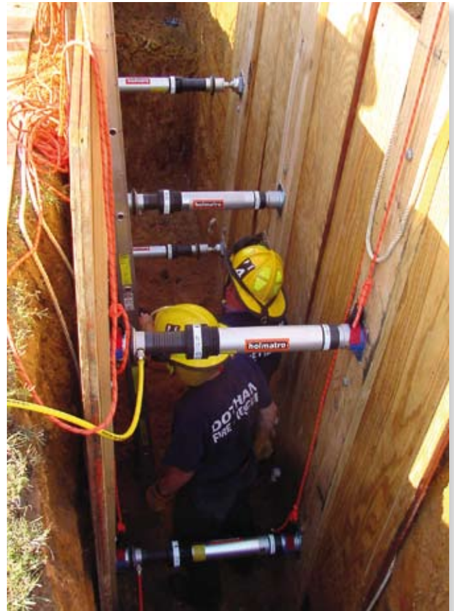
Árok kitémasztás pneumatikus önzáró „Auto-lock” támhengerrel
