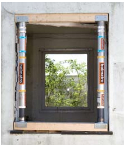
Ablak stabilizálása kézi támhengerek hosszabbítók, gerenda kengyel és gerendák segítségével.
