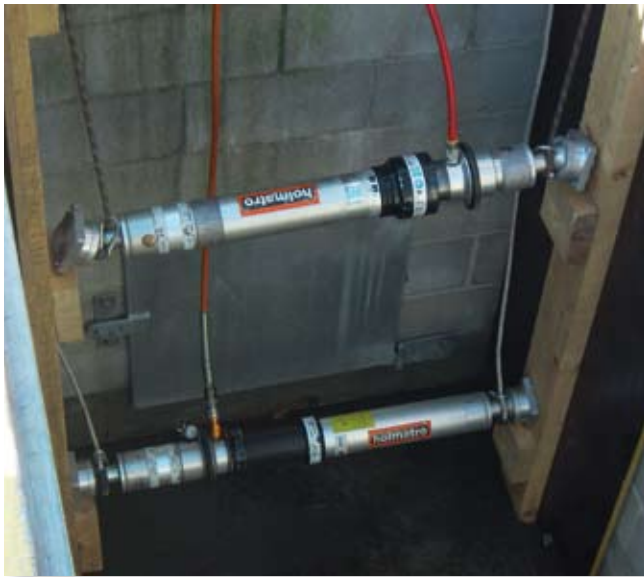
„Távolról támasztás” „Auto-lock” támhengerrel
